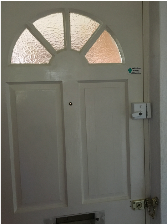
Kuva 3. Hätätilanne-tarra ulko-ovessa, ovenkahvan yläpuolella.
