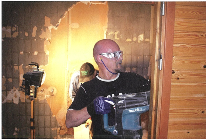
Leijonien vapaaehtoinen talkooväki teki ison työn vanhan saunan purkamisessa ja uuden rakentamisessa.
