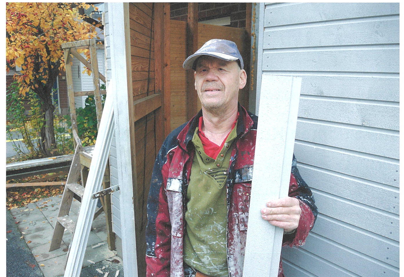
Ari Kääpä on tehnyt huoltotöitä vuodesta 2011 Toimintakeskuksella. Tämän vuoden aikana hän on korjannut rivitalojen ulkovarastot. Kuva: Pentti Pietiläinen.
